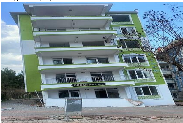
Рисунок 8. – Пример разжижения и частично наклоненного жилого дома в Гельбаши [9]
