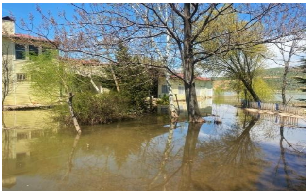
Рисунок 9. – Оседание грунта на озере Гельбаши в результате бокового распространения [9]
